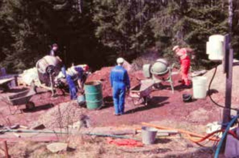
Grunden till den nuvarande huvudbyggnaden gjuts den 27 april 1989
