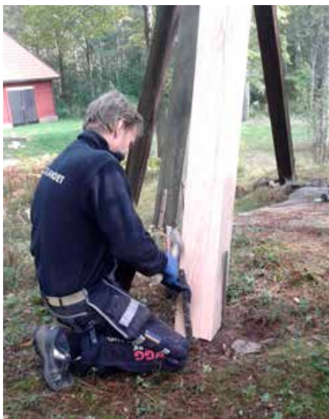
Tomas Axelsson placerar det nya stödbenet till klockstapeln på rätt plats i samband med arbetsdagen på Hembygdsgården den 16 september. Vid tidigare kontroll upptäcktes att ett av stödbenen var murket och nu har utbytet skett.
