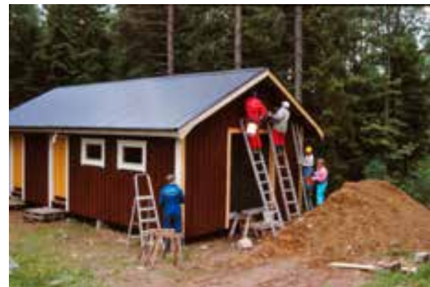
Förrådsbyggnaden färdigställes i juli 1996.
