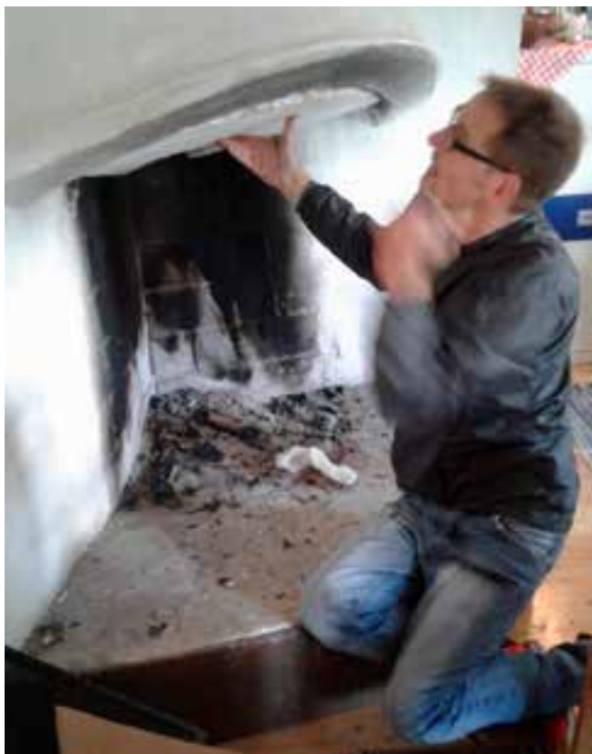
Magnus Ljunggren provar att placera en frigolitskiva i den öppna spisen för att undvika värmeförluster under vinterhalvåret.
